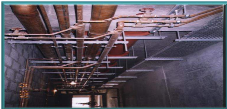
GPYW Sports Complex, Al - Hassa - KSA
