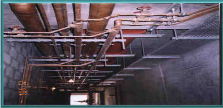
GPYW Sports Complex, Al - Hassa - KSA
