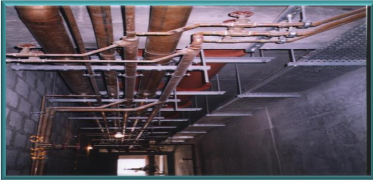
GPYW Sports Complex, Al - Hassa - KSA
